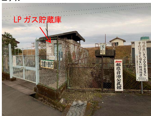
図 12-10 ポンプゲートの概要
