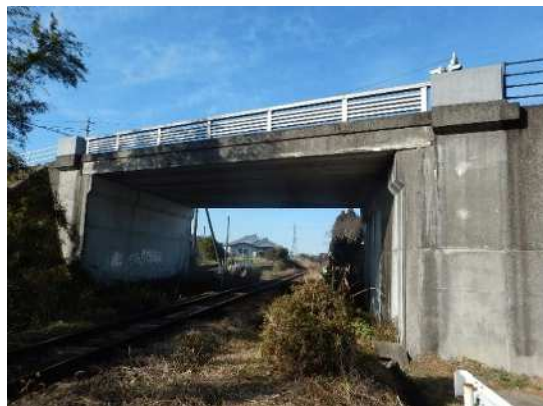
図 10 鉄道を跨ぐ橋梁の例（都城市管理 志比田陸橋）
