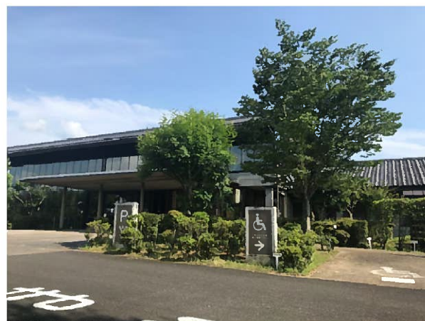
▲宮崎県木材利用技術センター
