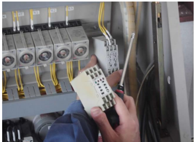
逆転検出装置センサー交換
