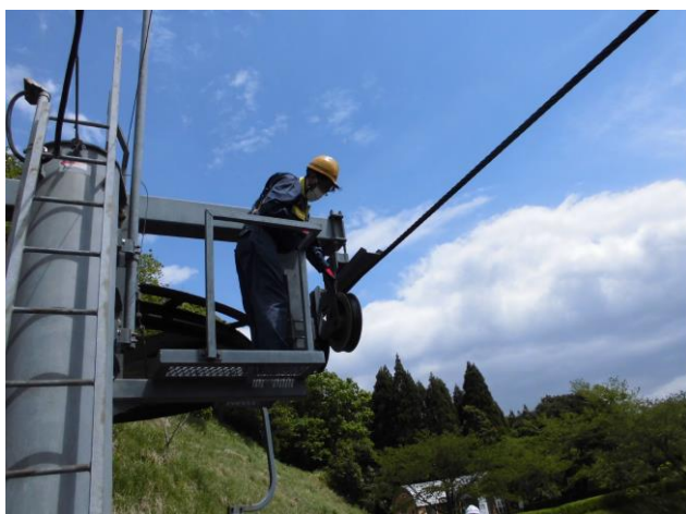
受圧索輪目視点検
