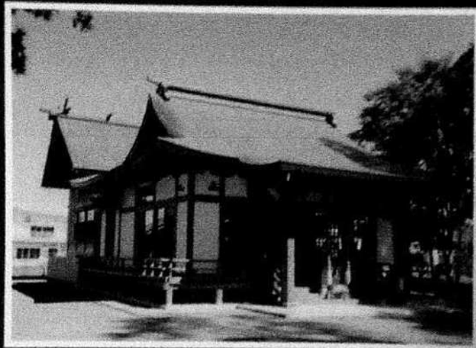
社殿が建替られた局津稲荷神社 (郡城市部元4丁目)
