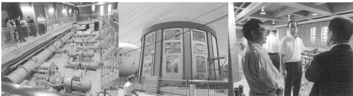
配水ポンプ（第2給水場）
