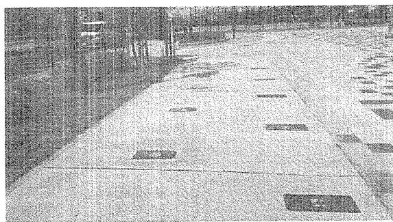
災害時に仕切り壁を設置し四角蓋の部分に仮便器を設置すると簡易トイレになる。
