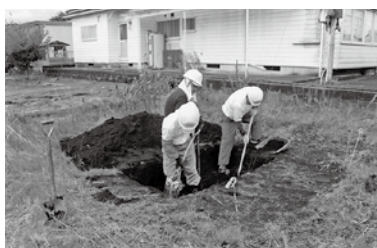
発掘・確認調査の様子
