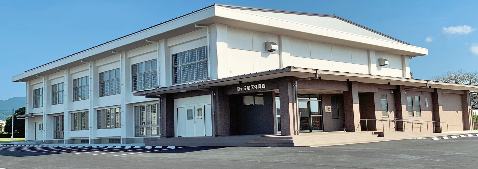
妻ヶ丘地区体育館完成(10月11日から使用開始)
