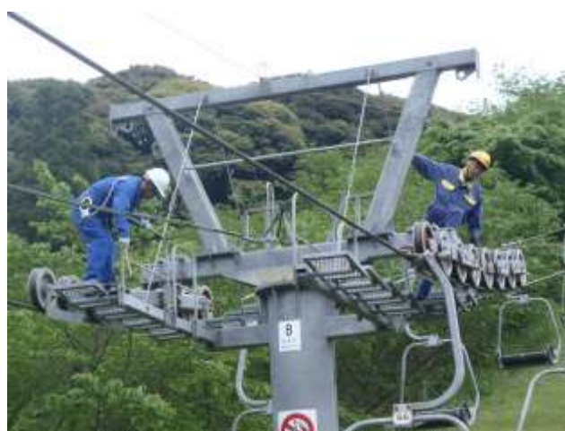
支柱打音検査
