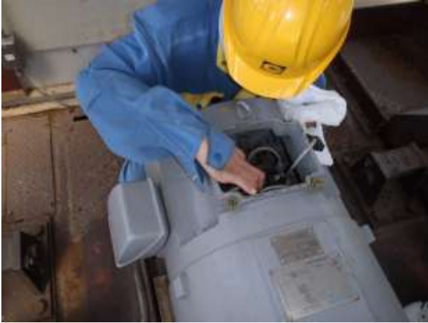
原動機点検整備
