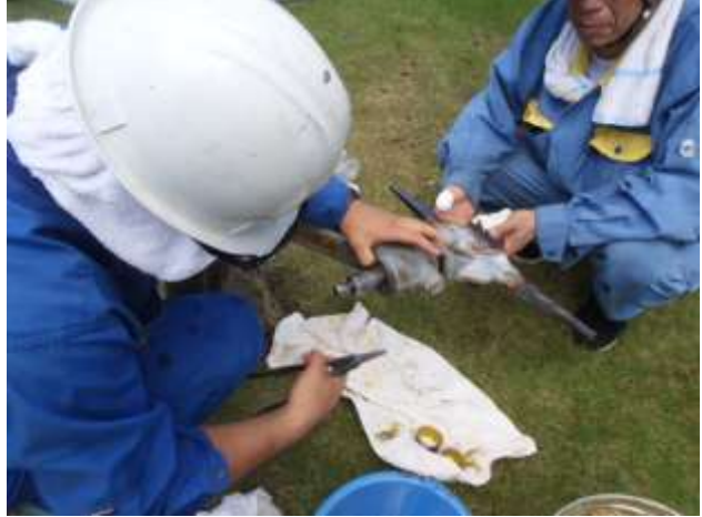
握索装置点検整備
