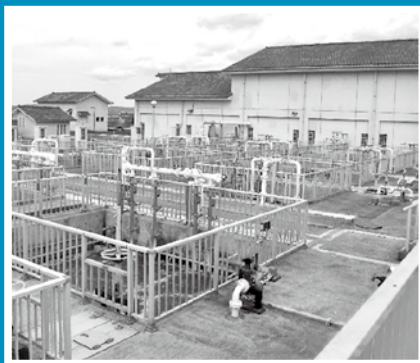
都城浄化センター（下水道施設）
