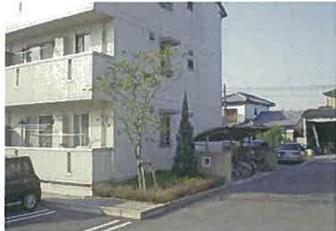
建築物本体と同様の形態・意匠に配慮し、植栽により周囲のまちなみ景観と調和が図られた駐車場及び駐輪場。
