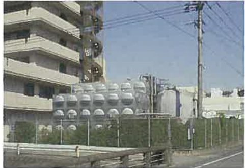
植栽で囲むことにより、周囲の景観と調和が図られている施設。
