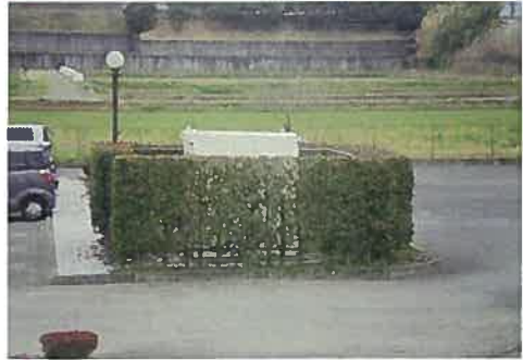
植栽で囲むことにより、周囲の景観と調和が図られている施設。
