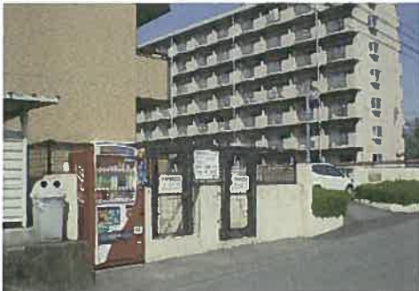
建築物と連続性をもたせ、みえかがりを少なくして周囲の景観に配慮されたごみ集積所。
