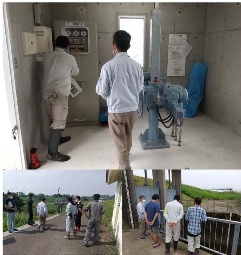
樋管総点検実施状況
