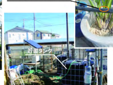
雨水を貯留タンク等に溜め、水道用水ほどの水質を必要としない 水洗トイレ、散水、その他の用途に使用するもの
