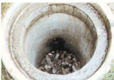
雨水ますの底部に穴を開け、その 周囲に砂利を敷きならべたもの
