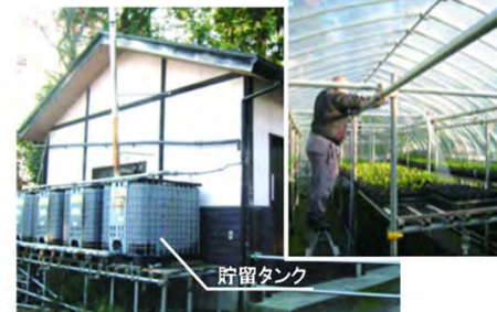
雨水を貯留タンク等に溜め、水道用水ほどの水質を必要としない 水洗トイレ、散水、その他の用途に使用するもの
