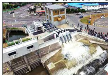
① 石塚雨水ポンプ場
