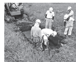
試掘・確認調査の様子
