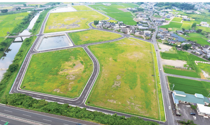
南地区を都城IC側から撮影
