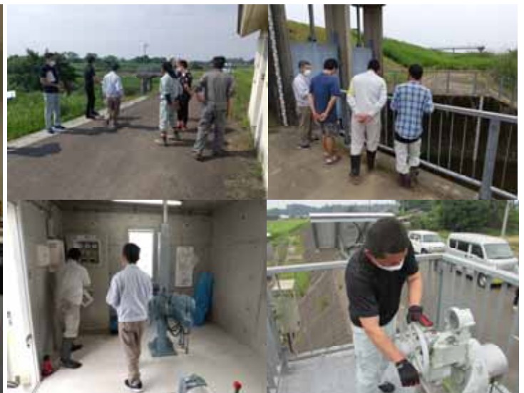
令和4年5月 合同点検、操作訓練
