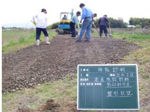
【 路面の補修・砂利の敷き均し 】
