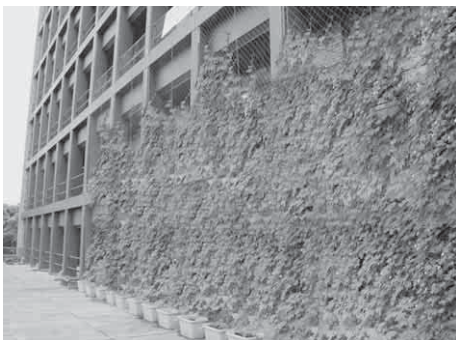
市役所に設置されたグリーンカーテン（イメージ）
