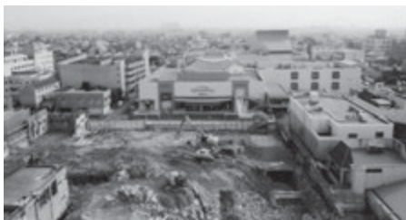
敷地整備が進む中核施設整備予定地
