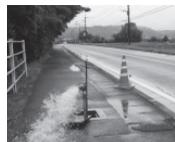
水道管は、消火栓などから放水し、水の勢いで水道管の内側に付着した沈殿物などを除去します。そのほか、配水池も定期的な掃除に砂の除去などの清掃を行っています。
