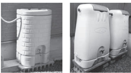
雨水貯留施設の設置例
