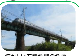
懐かしい石積鉄脚の鉄橋。電車が通ればラッキー！！
