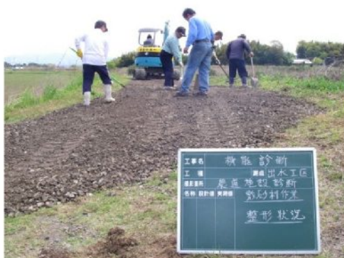
【 路面の補修・砂利の敷き均し 】
