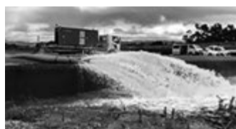
宅地側内水を河川に排水
