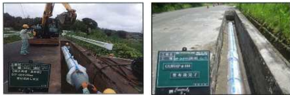
基幹管路整備状況
