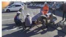
ジャッキやパル等の身の回りにあるものを使用して、倒壊した家屋から救助を実施する。
