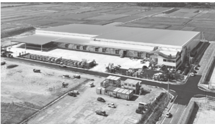
都城インター工業団地
