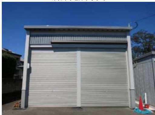
倉庫完成写真
