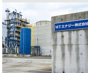
木質バイオマス発電施設を備えるMT エナジー株式会社
