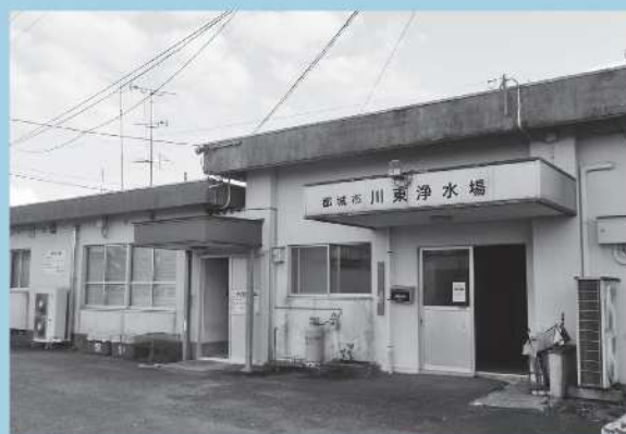
川東浄水場(外観)
