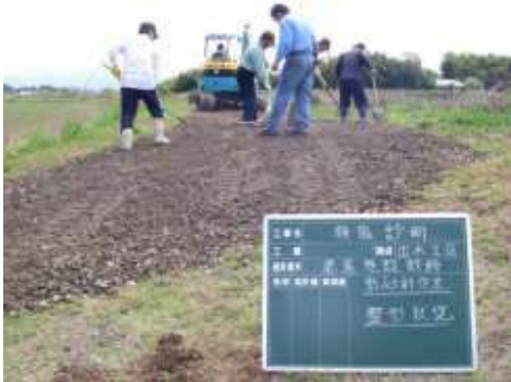
【 路面の補修・砂利の敷き均し 】
