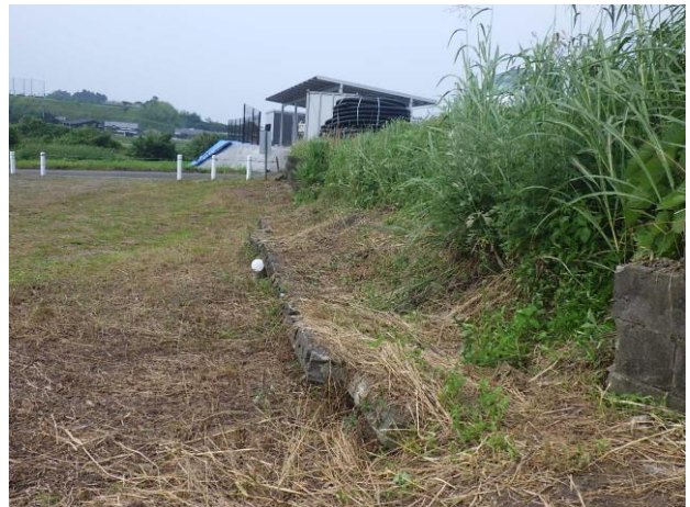
F 南東側ブロック状況
