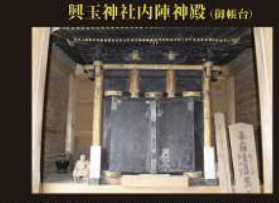
興玉神社内陣神殿（御帳台） 内神殿（厨子）が昭和58年6月、国の重要文化財に指定。 応永6年（1399年）の製作で現在南九州最古の建造物とされている。
