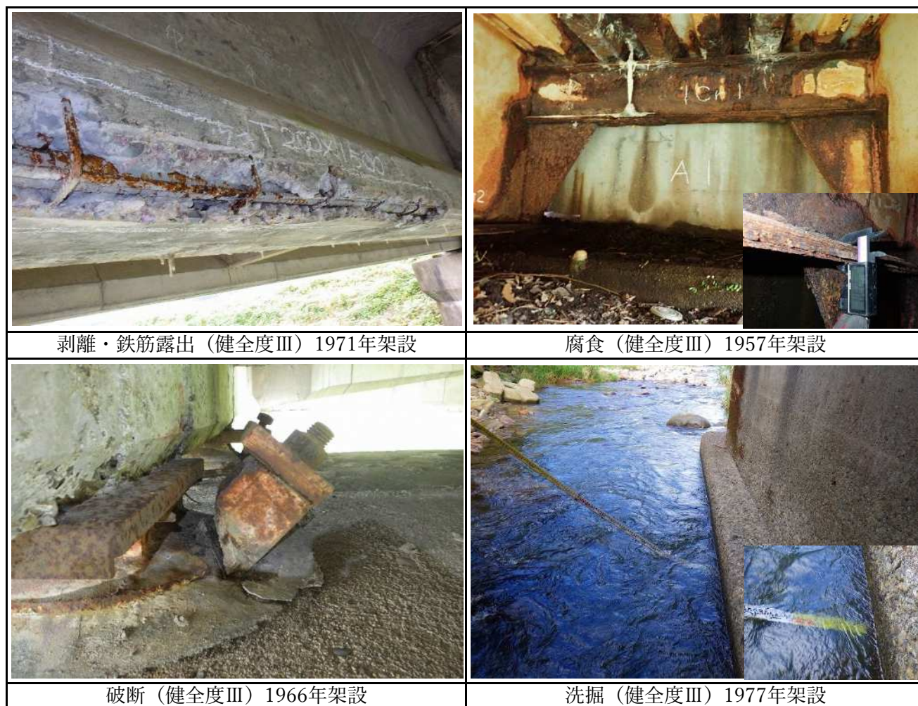
図 6 損傷状況
