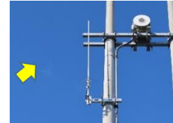
サイレン塔に設置したアンテナ
