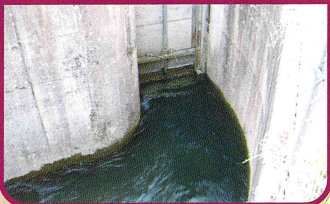
② 南前用水路取水口 (鉄製の水門)
