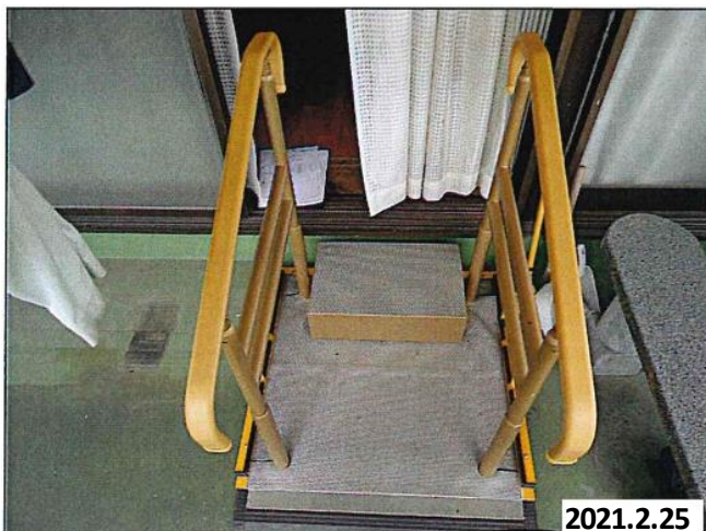
③ 勝手口両手すり付きステップ台 W600×D300×H140 500×H800
