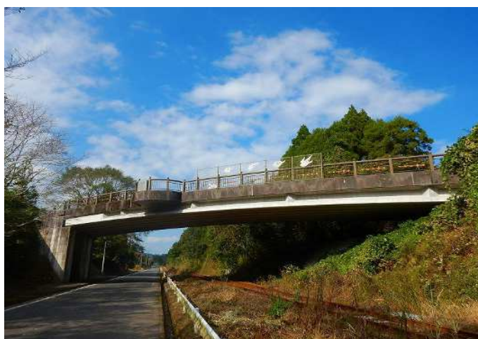
図10 道路・鉄道を跨ぐ橋梁の例（都城市管理 東神橋）
