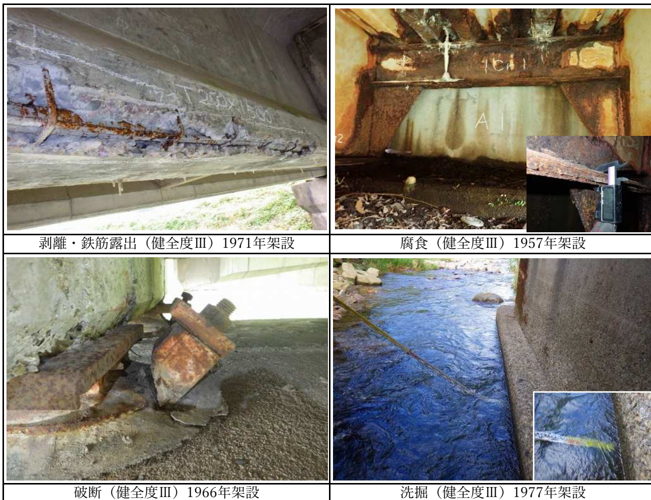
図 6 損傷状況
