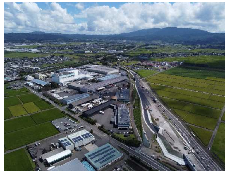
都城IC付近（手前は都城志布志道路と高木工業団地）
