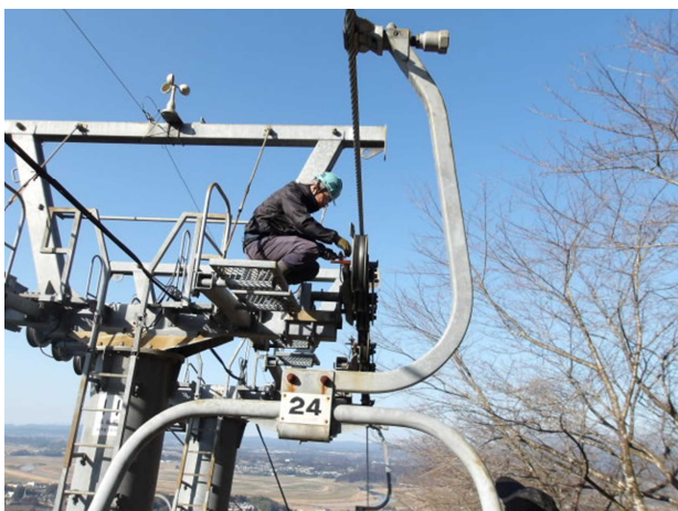
脱索検出装置作動確認
