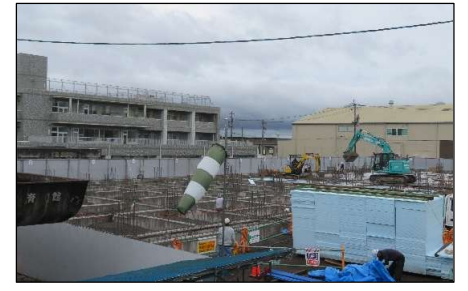
公民館の鉄筋 立上げの様子 ⇒
