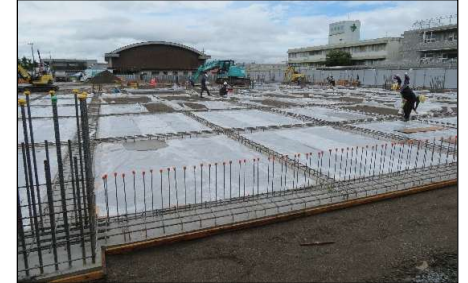
体育館の基礎 工事の状況 ⇒
