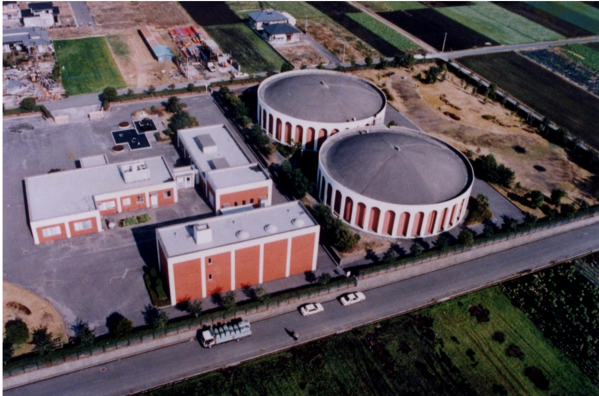
一万城浄水場（S58：完成時）
