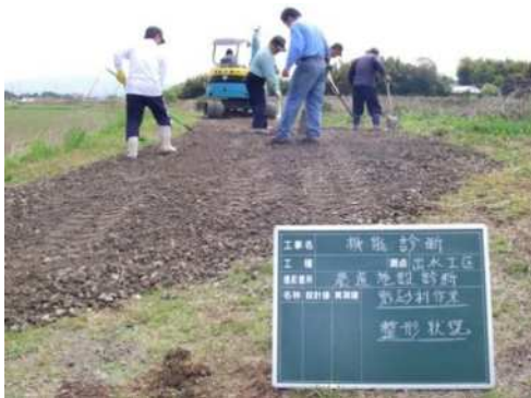
【 路面の補修・砂利の敷き均し 】
