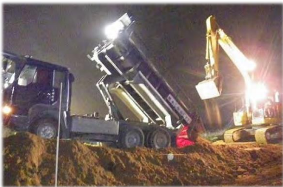
災害復旧工事の様子
