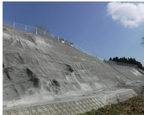
急傾斜地崩壊対策事業
