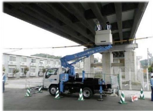
橋梁の定期点検
