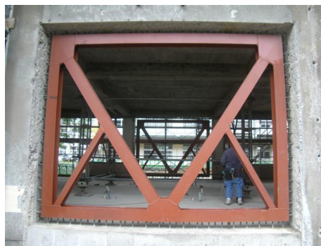
施工例：姫城中補強
