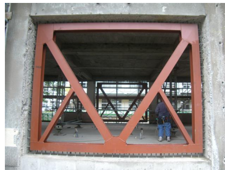
施工例：姫城中補強
