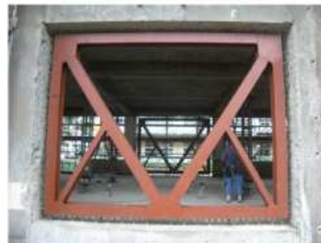
《施工例: 姫城中補強》
