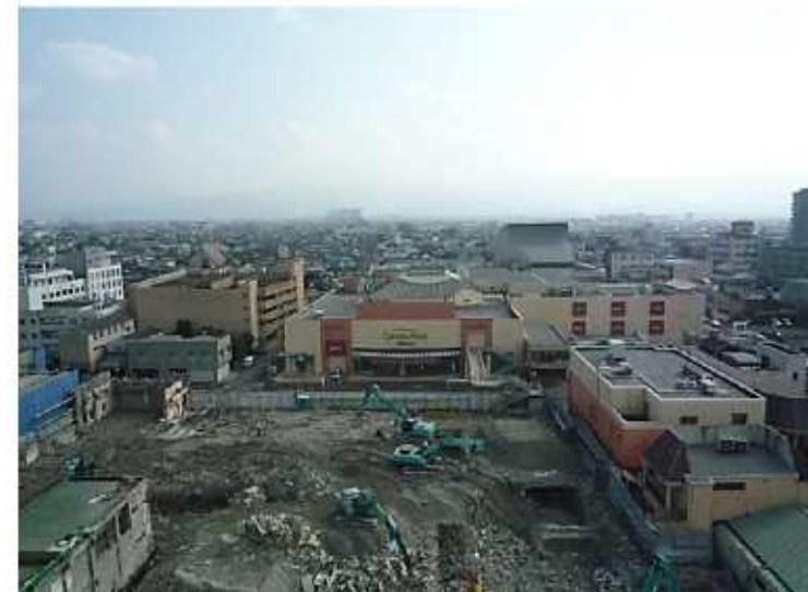
《敷地整備が進む中心市街地中核施設施設整備予定地》
