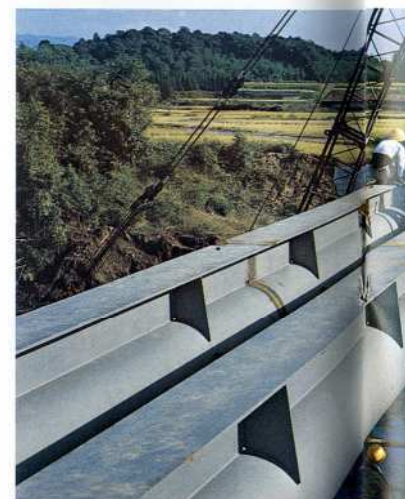
▲ 工事中の横市水管橋（長さ
