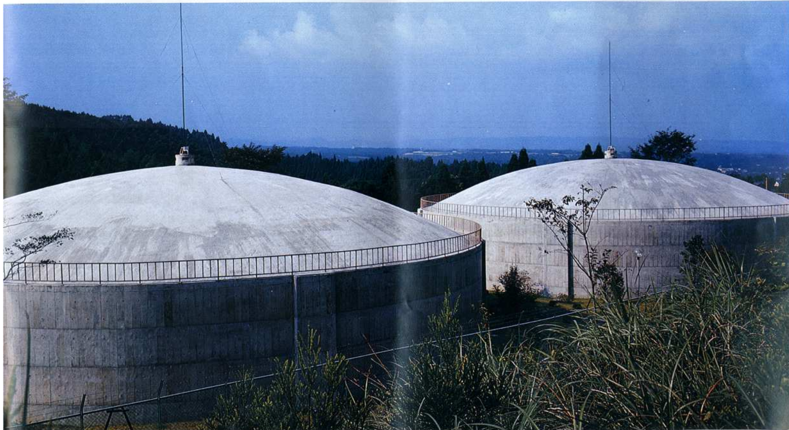
▼ ももひ 母智丘配水池（高さ12m、直径33m、容量6,000m 3 ×2基、標高204m）
