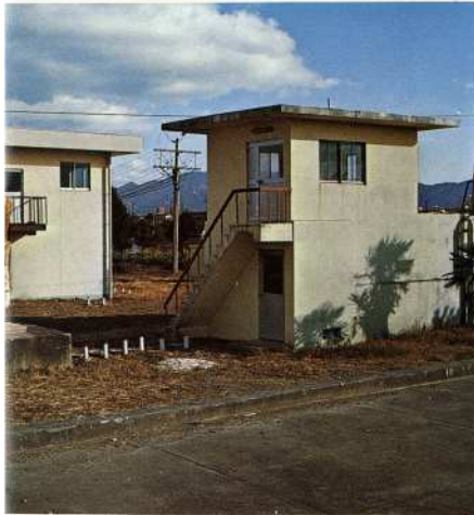
▲ 川東浄水場着水室・塩素滅菌室
