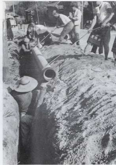
▲ 配水管埋設工事
