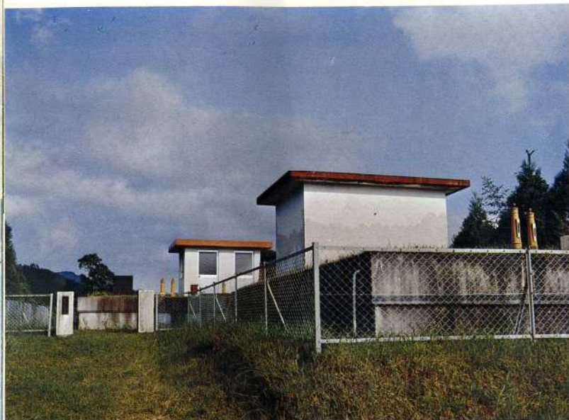
▲ 前が大浦配水池（容量105m 3 ）後方が今町配水池（容量172m 3 ）
