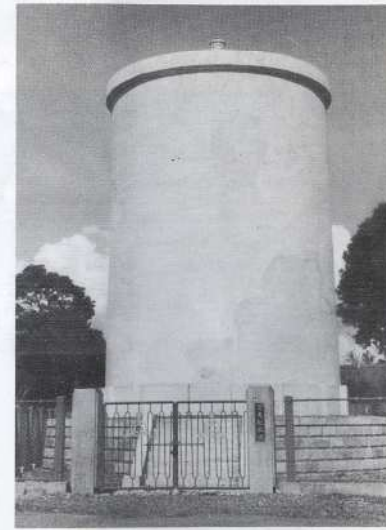
▲ 鷹尾配水塔 (容量180 \text{m}^3 )
