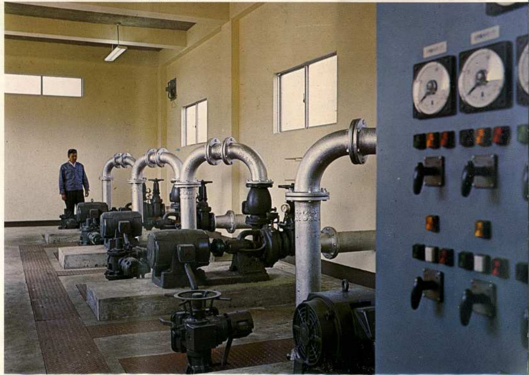
▼ 高蒲原浄水場配水ポンプ (22kW×4台)
