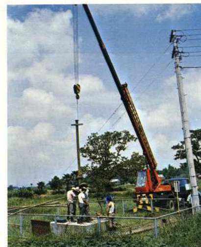
▲ 水中ポンプの取替作業 (中郷第3号井)
