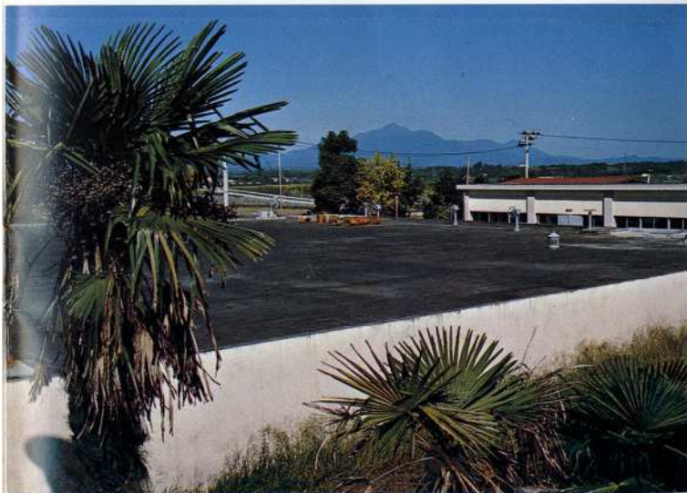
▲ 川東配水池 (容量2,680m 3 )、現在浄水池として使用
