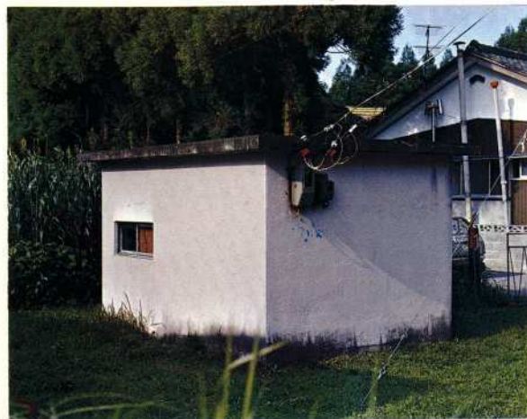
▲ 大浦ポンプ室
