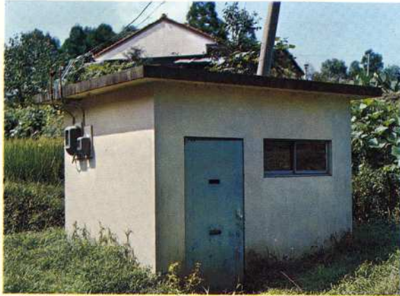
▲ 豊満ポンプ室
