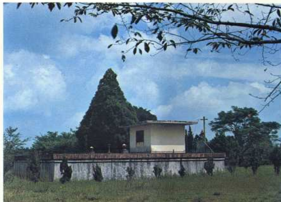
▲ 庄内配水池 (容量526m 3 )
