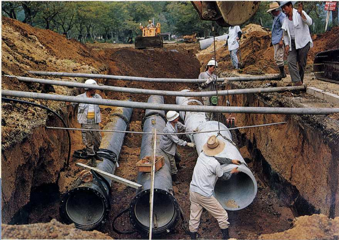
▲ 母智丘神社参道の送配水管埋設工事 左から送水管、配水管（鑄鉄管） 排水管（コンクリートヒューム管）、管径はいずれも600mm
