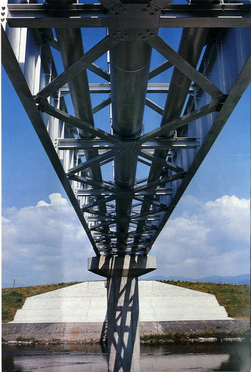
▶ 赤星水管橋 (長さ100m・中央600mm 送水管、両側300mm 湧水管)
