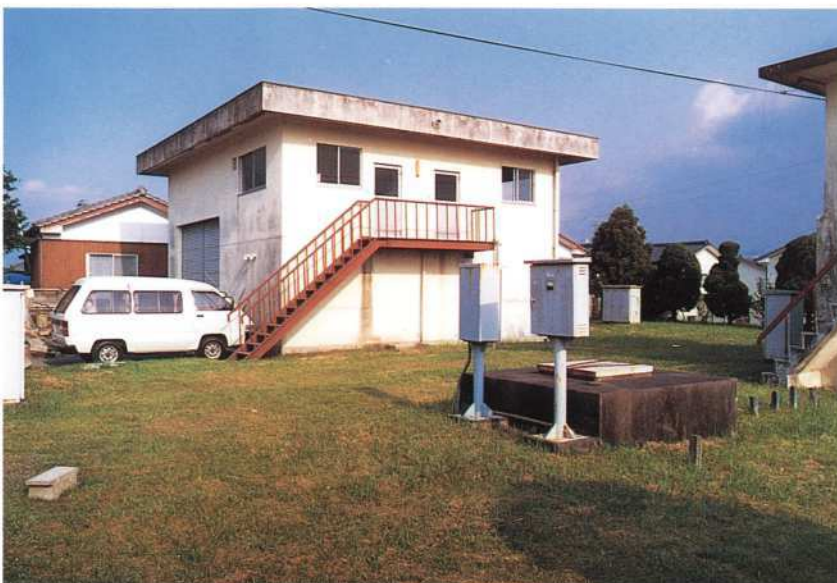
塩素滅菌室▶ 着水池
