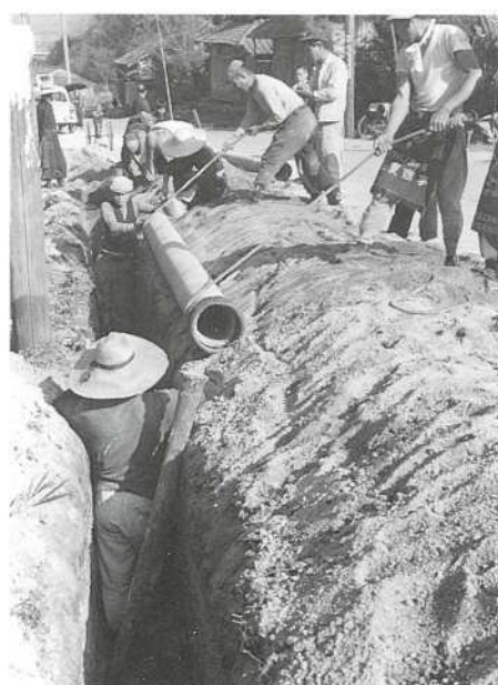
▲配水管埋設工事
