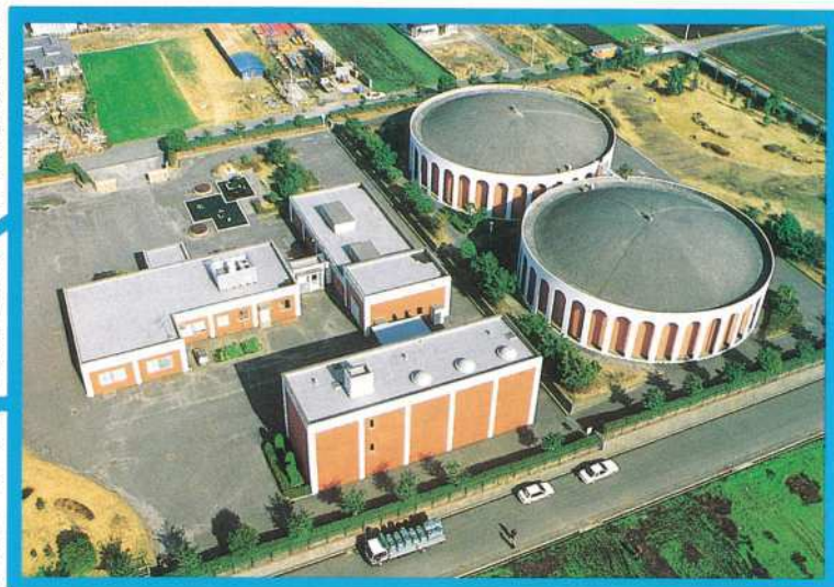
一万城浄水場 配水能力—22,000m 3 /日
