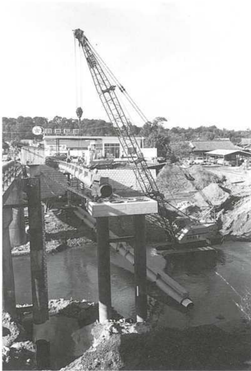
▲工事中の横市水管橋 (長さ50m、送配水管600mm)
