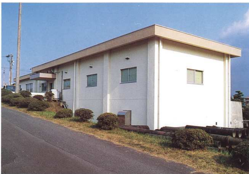
送水ポンプ室▶ 電気室
