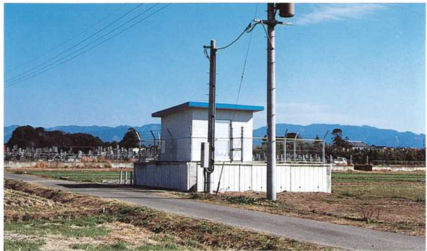
取水ポンプ室 ▶ 14号井
