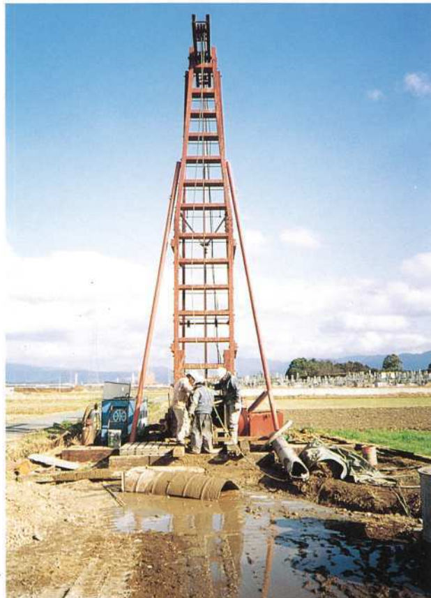
15号井 ▶ さく井工事
