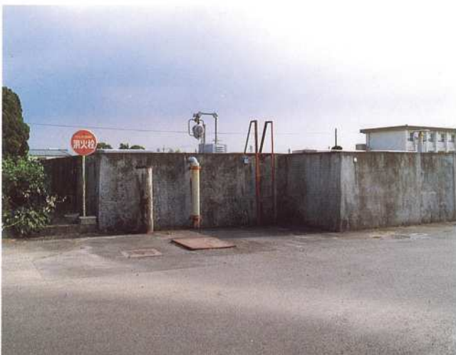
▲川東配水池（容量2,680m 3 ）、現在浄水池として使用
