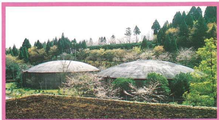
母智丘配水池 6,000m 3 ×2基
