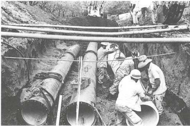
▲母智丘神社参道の送配水管埋設工事 左から送水管、配水管(鑄鉄管)、排水管(コンクリートヒューム等) 直径はいずれも600mm
