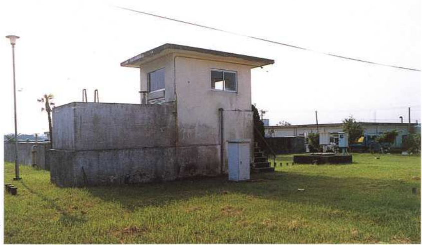
着水井 ▶ (容量6,000m 3 ×2基)
