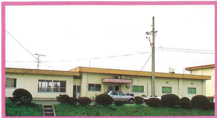
川東浄水場 配水能力—23,500m 3 /日
