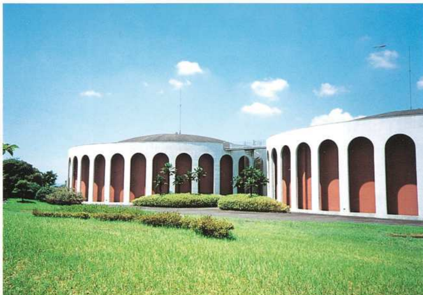
配水池▶ (容量5,600m 3 ×2基)
