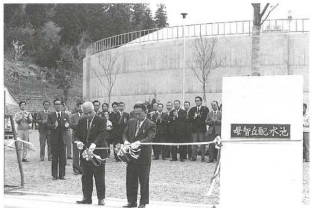
▲第2次拡張事業の通水式(昭和50年4月7日)
