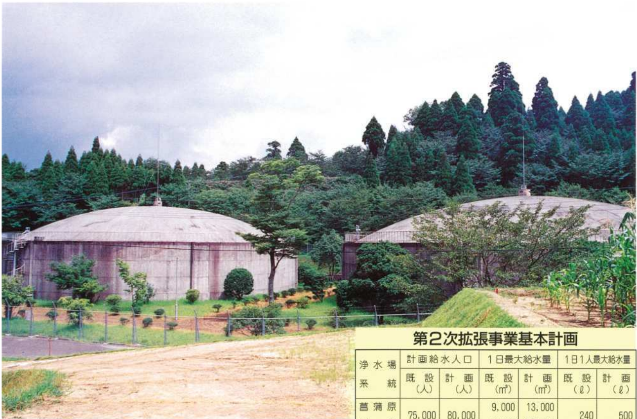
▲母智丘配水池 (高さ12m、直径33m、容量6,000m 3 ×2基、標高204m)
