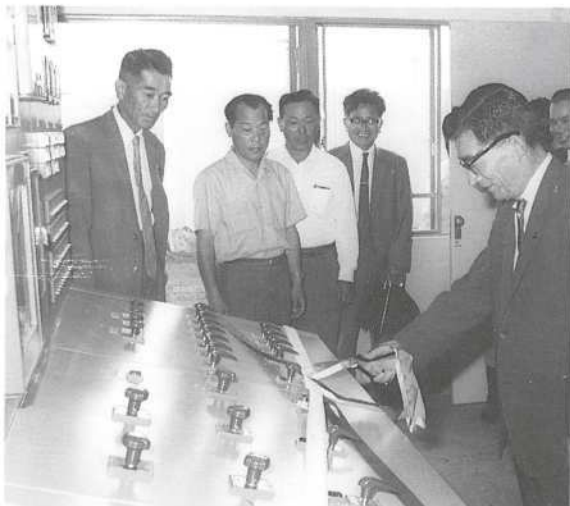
▲川東浄水場始動式（昭和41年7月7日）
