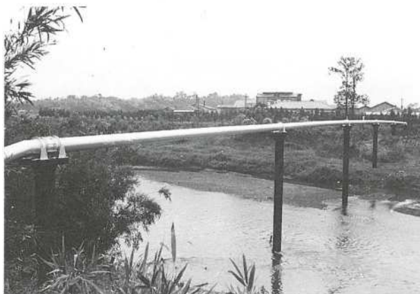
▲赤星水管橋、昭和46年に撤去し、赤星橋へ添架
