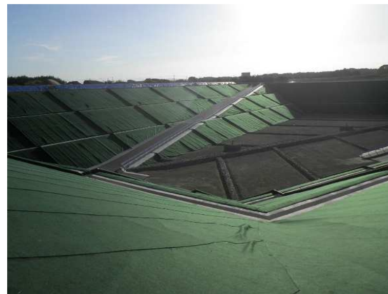
写真は第2期処分場の建設完了時
